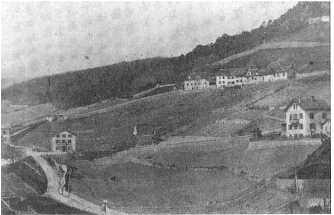
Fig 3: Vue du carrefour de Vauseyon et de la colline du Suchiez vers 1860 juste après l'ouverture de la Route des Gorges
